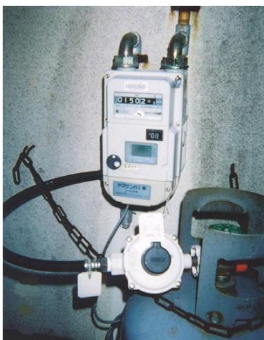
調整器の取付姿勢が悪いため、雨水がカバー内に入り内部部品が腐食するおそれがある。
