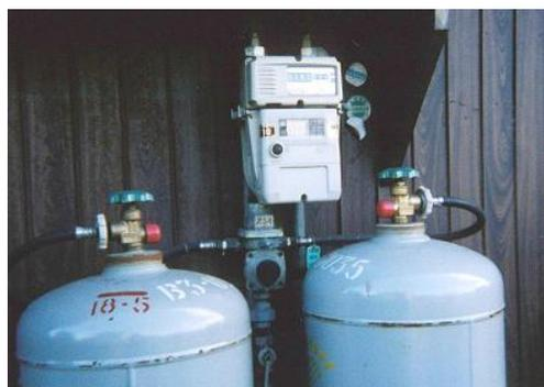
高圧ホースが調整器に向って下り勾配となっているため、再液化により調整器の弁ゴムが劣化するおそれがある。
