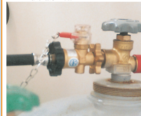
高圧部からのガス漏えいを防止する安全機器で、張力式と過流式があります。
