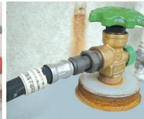
ガス放出防止機能が内蔵された高圧ホースです。(張力式)
