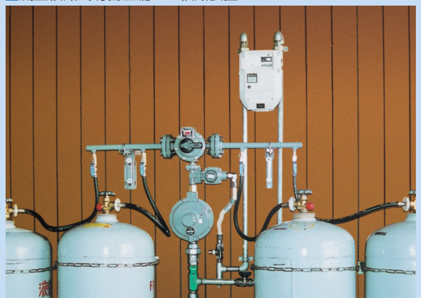
LPガス未使用時に微少なガス漏れがあると、セットされた検知器によりガス漏れを表示する安全機器です。埋設管等の設備に効果を発揮します。
