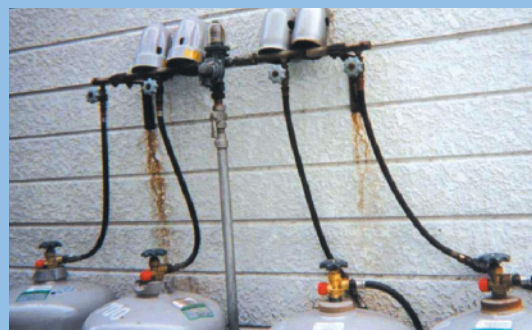
高圧ホースが長く、たるんでいると、再液化現象により容器交換時にガス放出量が多くなります。
